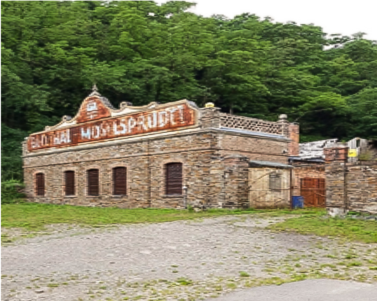
Im Vordergrund ehemaliges Bürogebäude mit dem Firmenschild, dahinter die Produktionshalle.
